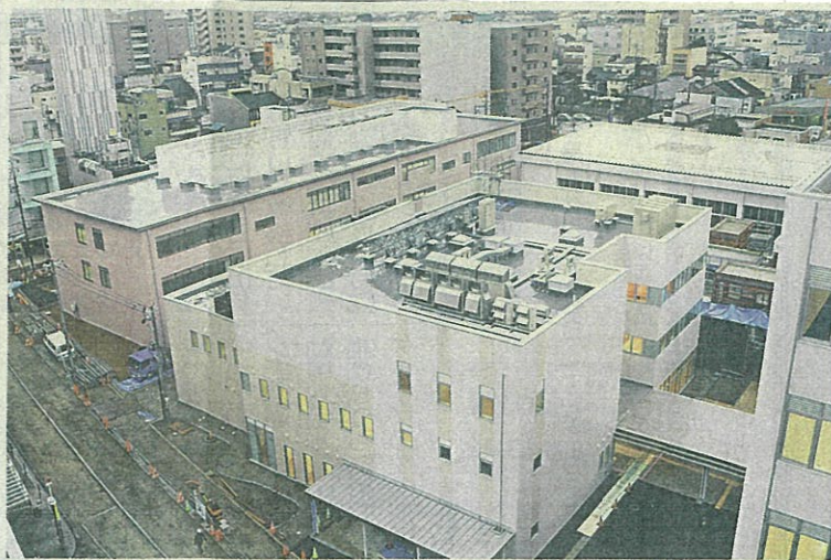
富山県が旧総曲輪小学校跡地で整備を進めている「まちなか総合ケアセンター」。4月にオープンし、産後ケアや訪問診療など各種事業が実施される
